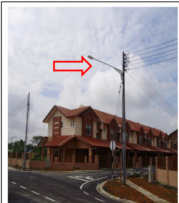
Kabel Atas Dipasang Selari Dengan Jalan Dikawasan Kediaman
