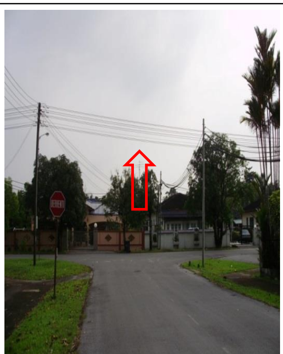
Jika Kabel Atas Yang Melintasi Jalan Dan Telah Kendur Dengan Ketinggian Kurang Daripada 600mm Hendaklah Di Pasang Semula Dengan Cara Melalui Bawah Tanah Mengikut Spesifikasi Yang Telah Ditetapkan
