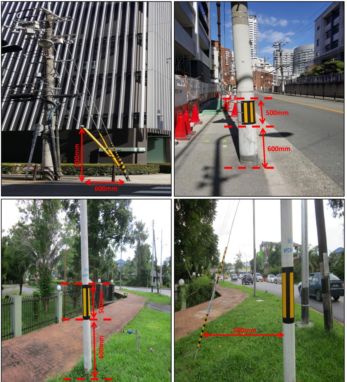
Pemasangan Penanda Jalur Kuning Dan Hitam Pada Tiang Dan Stay Wire Elektrik Dan Telekomunikasi
